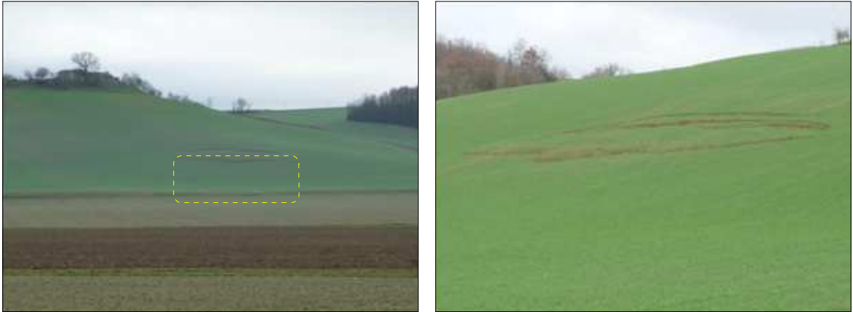
Figure 23 : Glissement superficiel à la Ritonne, observé en 2013 dans les formations argilo-gréseuses de l'Oligocène, sur la commune de CASTELSAGRAT [Source : IMS RV ]
