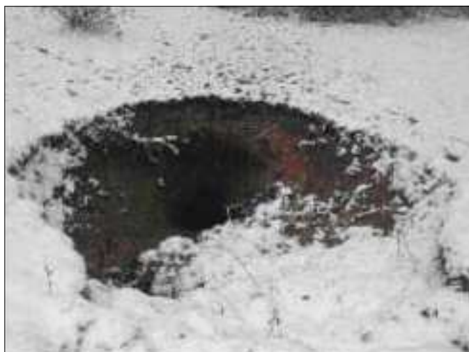
Figure 14 : Effondrement d'une zone sous-cavée par suffosion [Source : BRGM]
